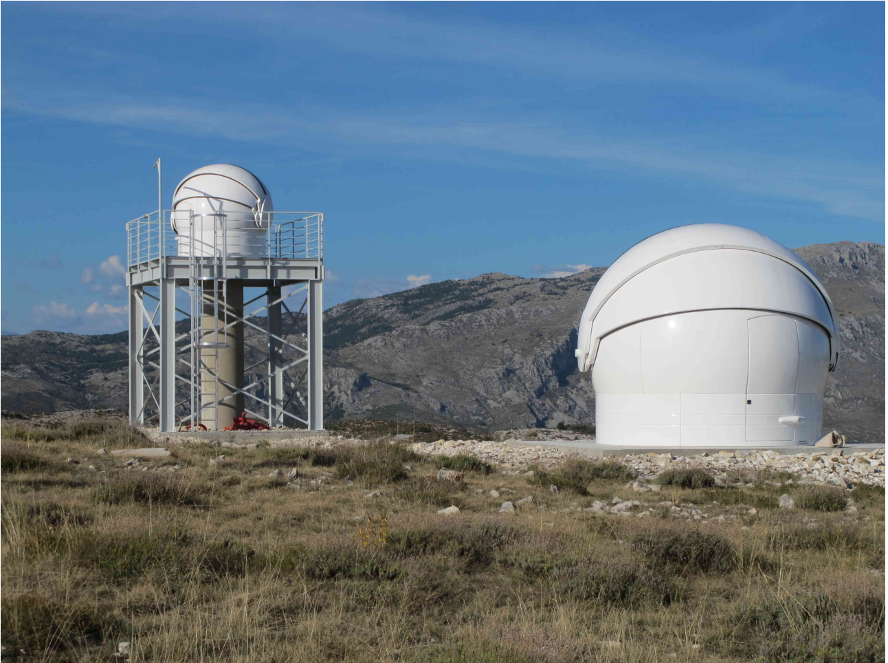
Vue d'ensemble de la station CATS à Calern.
